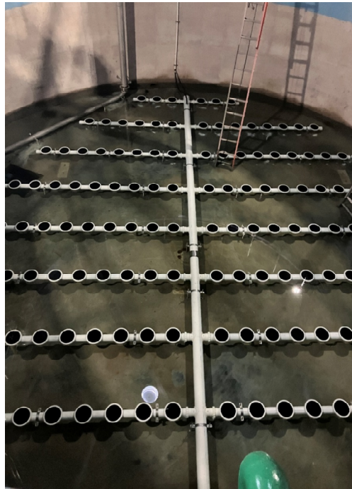
Str. 70 - Diffuser Grid
